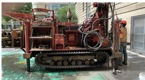
Travaux de forage pour analyser l'état du sol
